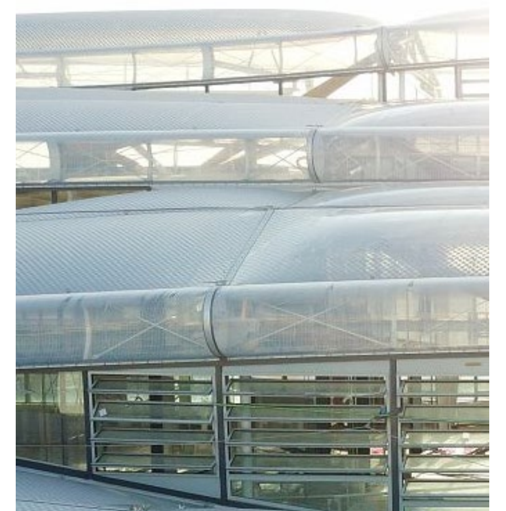
Gare de Rennes et sa toiture en coussins d'ETFE (Source AREP)
